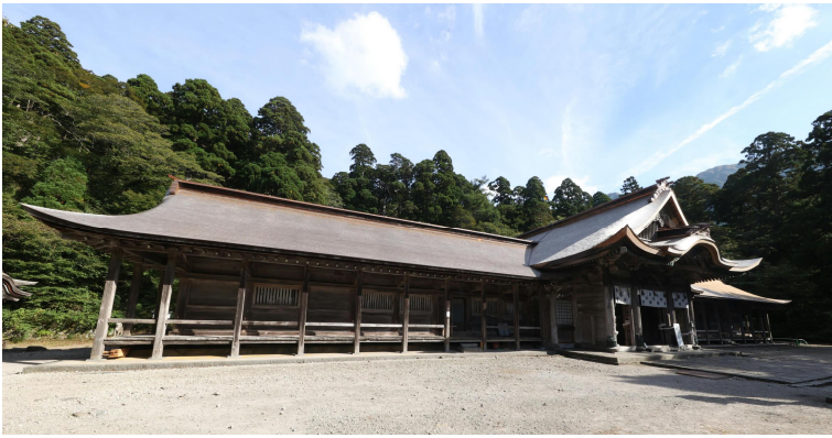
完成した御社殿
